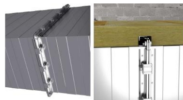
6.2 pav. Izoliacinių plokščių montavimas flanšų vietose
