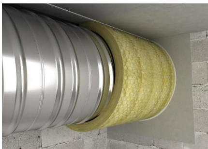
5.5 pav. Ortakio izoliavimas kai atstumas iki konstrukcijos \leq 200\text{mm} ir daugiau nei izoliacijos storis
