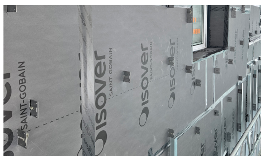
1 pav. Suleidimo įpjovos ISOVER Facade plokščių ilgosiose briaunose
