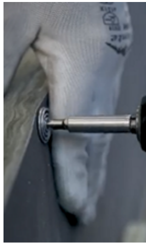
9 pav. ISOVER Facade plokščių kampinių jungčių sutvirtinimas spiraliniais sraigtais Isover Fire Protect Screw
