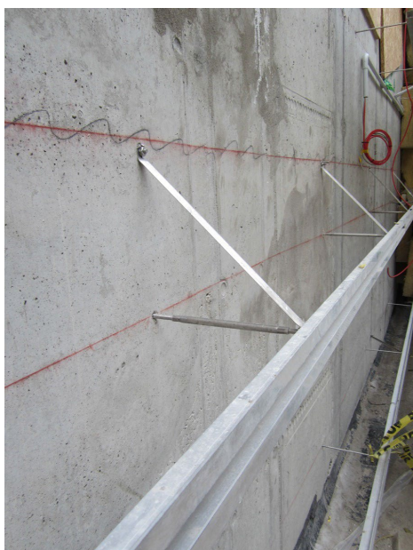
14 pav. Vėdinamas fasadas su nerūdijančio plieno strypų konstrukcija
