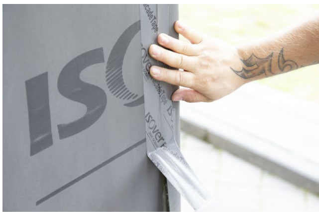
16 pav. ISOVER Facade siūlių sandarinimas lipnia juosta ISOVER FacadeTape .
