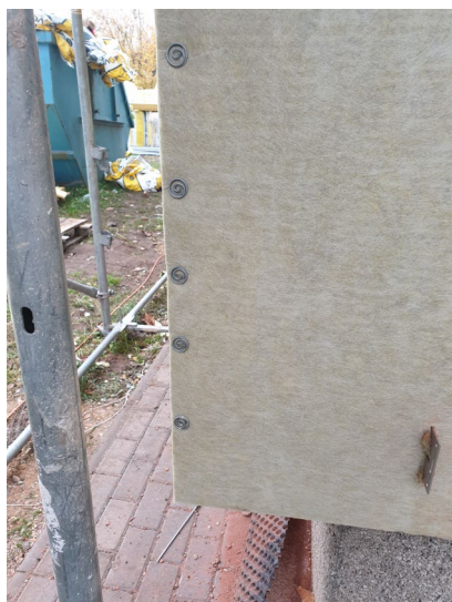
17 pav. Kampinių jungčių mechaninis tvirtinimas sraigtais ir sandarinimas lipnia juosta Isover FacadeTape
