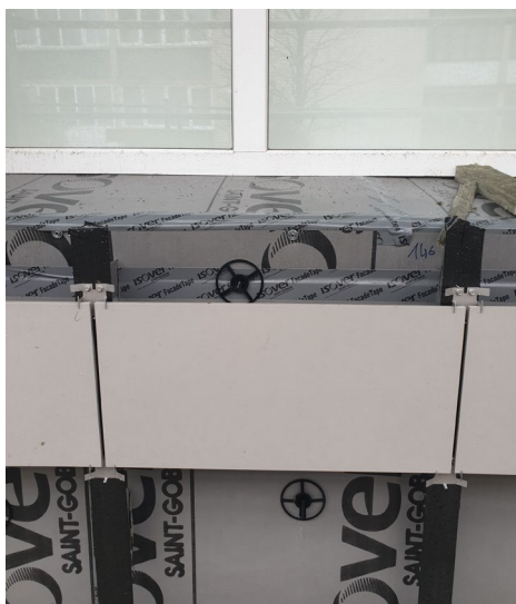
17 pav. Kampinių jungčių mechaninis tvirtinimas sraigtais ir sandarinimas lipnia juosta Isover FacadeTape
