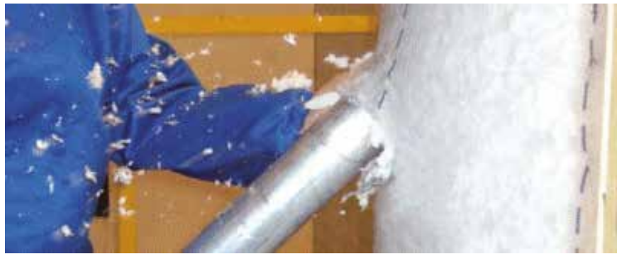
InsulSafe vatos pūtimas per „Isover Wall blanket“ plėvelę.
