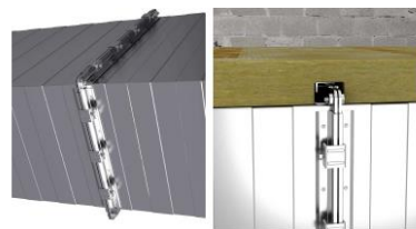
6.2 pav. Izoliacinių plokščių montavimas flanšų vietose
